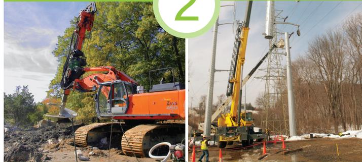
Las nuevas estructuras se instalarán dentro del corredor de los cables eléctricos. Se utilizará un taladro grande o excavadora para perforar la tierra y crear los cimientos para cada estructura.
