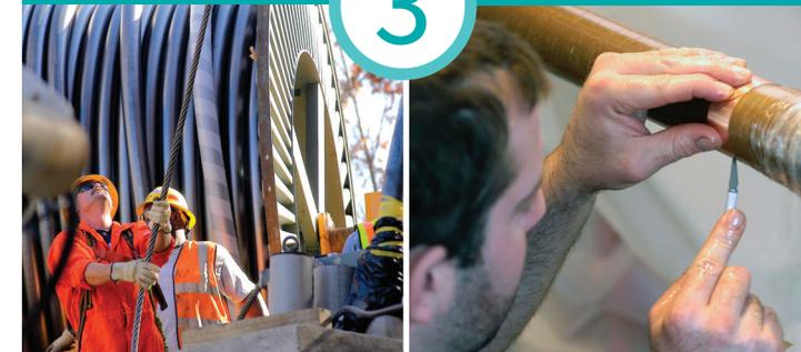
La instalación de los cables se hace después de instalar los conductos y las alcantarillas. El cable se toma de un rollo de cable eléctrico y se coloca entre las alcantarillas y estructuras en todo el trayecto.
