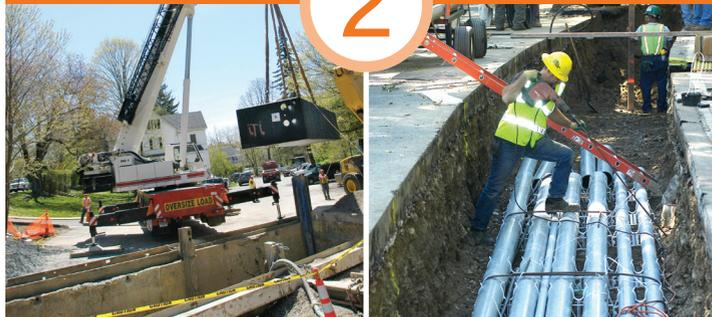
Luego de inspeccionar los servicios públicos existentes, se instalarán alcantarillas en todo el trayecto. Las alcantarillas son bóvedas de concreto instaladas para permitir que las cuadrillas coloquen y conecten los cables nuevos.
