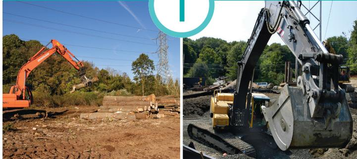
Antes de empezar la construcción, inspeccionaremos el corredor de cables eléctricos en áreas con derechos de paso. Eliminaremos la vegetación, donde sea necesario para mantener distancias seguras y poder crear un área de trabajo segura y emparejar el suelo.
