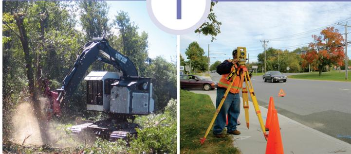
Antes de comenzar la construcción, inspeccionaremos la ubicación donde se instalarán los cables bajo tierra y marcaremos los servicios públicos existentes. También podríamos hacer pruebas para determinar la condición del suelo bajo la superficie.
