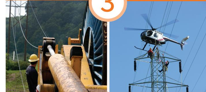
Una vez que se colocan las estructuras, se instalan los nuevos cables eléctricos. Cada estructura cuenta con poleas temporales donde se amarran los cables a la estructura. A lo largo del corredor de los cables eléctricos se establecen áreas donde se ajustan los cables. Los cables se ajustan en estas zonas a través de las poleas en cada estructura.
